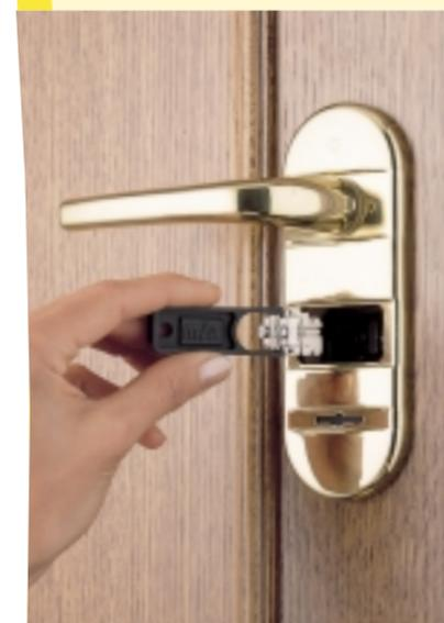
Sempre con l'apposito estrattore inserire il bloccetto definitivo e avvitare le due viti di fissaggio.
